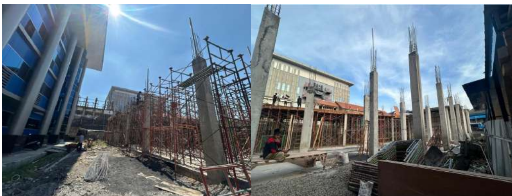
Gambar 1. Foto Proyek Pembangunan Masjid Baabush Sholihin Kampus UNITOMO
